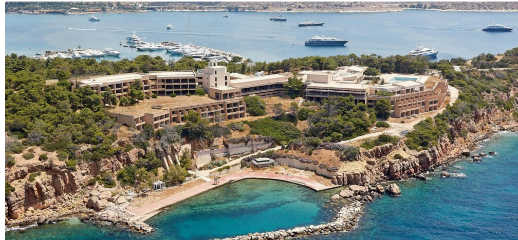
ΓΕΝΙΚΗ ΑΠΟΨΗ ΤΟΥ ΚΤΙΡΙΟΥ ΑΠΟ ΤΟΝ ΝΟΤΟ
